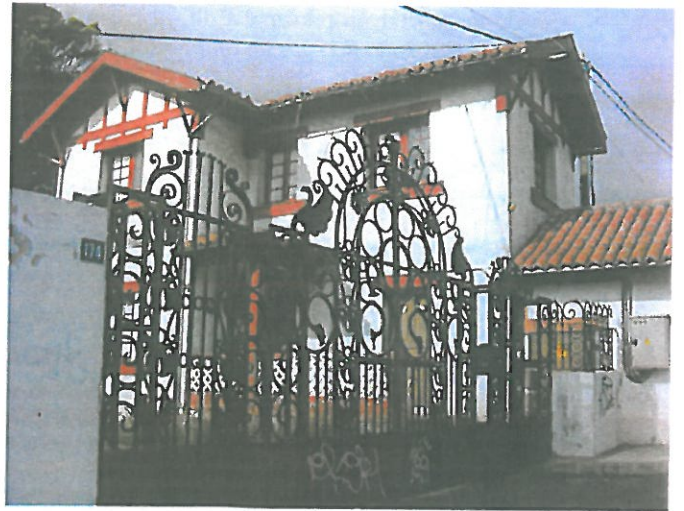
Ubicación actual de la verja de metal de entrada
